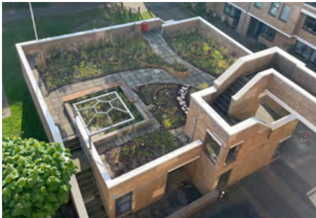
Vergroenen dakterras Fongersplaats, Groningen
